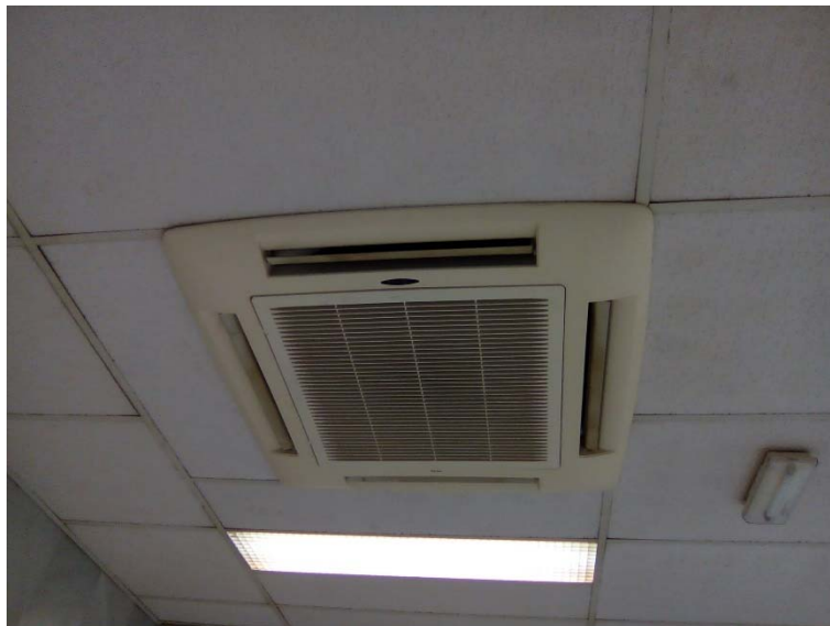
Imagen 13. Unidades interiores cassette 4 vías Carrier en pasillo público.
