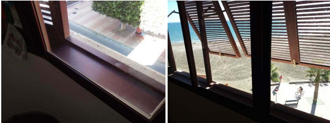
Imagen 31. Carpintería de aluminio sin RPT con vidrio monolítico
