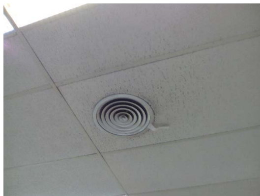
Imagen 17. Difusor de aire cónico de lamas fijas
