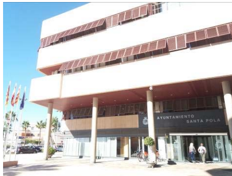
Imagen 4. Voladizo - protección solar fija
