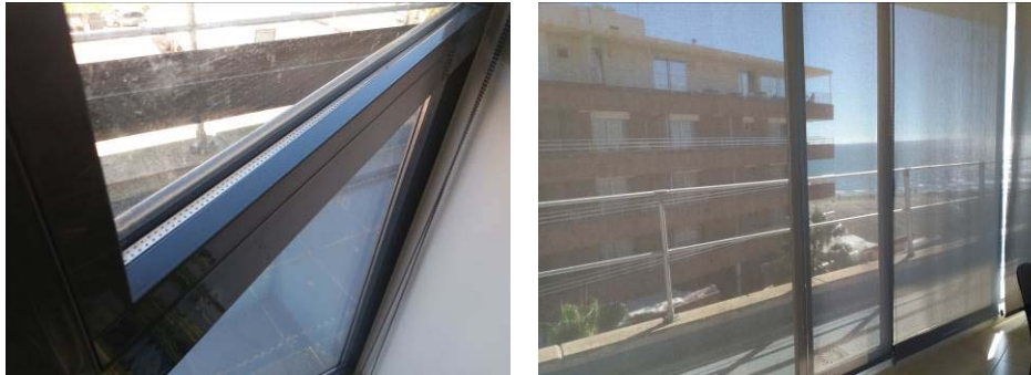
Imagen 3. Dispositivo interior de protección solar
