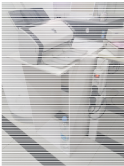
Imagen 19. Regletas de enchufes con interruptor manual en puestos de trabajo
